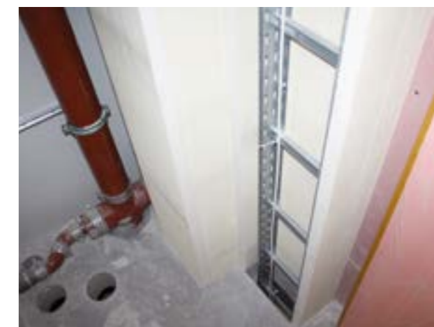
Figura 3: Schema tipologico con impianti di varia natura che possono essere valutati separatamente in accordo alla norma EN 1366-5 o EN 1366-1 in lastre PROMATECT®-L500 a protezione di impianti di qualsiasi natura o per rivestimento di condotte metalliche EI 120 (ve-ho i <->o)S 500 Pa
