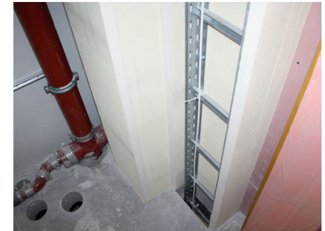
Figura 3: Schema tipologico con impianti di varia natura che possono essere valutati separatamente in accordo alla norma EN 1366-5 o EN 1366-1 in lastre PROMATECT®-L500 a protezione di impianti di qualsiasi natura o per rivestimento di condotte metalliche EI 120 (ve-ho i <->o)S 500 Pa
