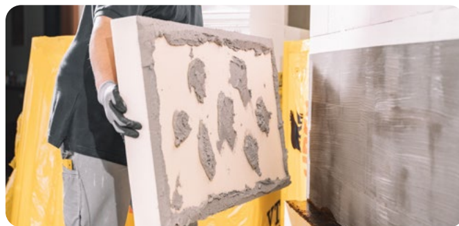
Bild 1: Auftragen des Bauklebers im Punkt-Wulst-Verfahren
