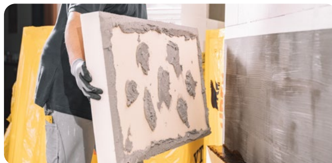
Bild 1: Auftragen des Bauklebers im Punkt-Wulst-Verfahren
