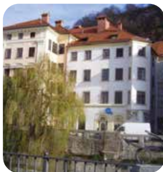
Primer objekta po prenovi. Vir gradiva: GIVO, d.o.o., Ljubljana
