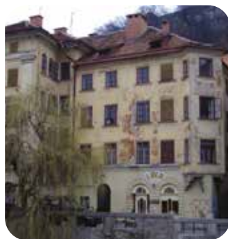
Primer objekta pred prenovo
