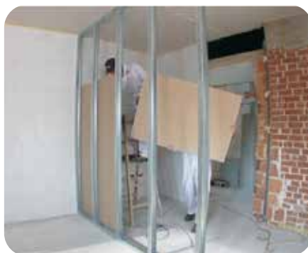
2: Namestimo prvi sloj mavčnokartonskih plošč
