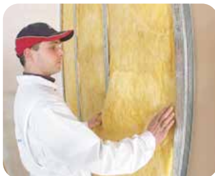
5: Pomembna je natančna vgradnja toplotne in zvočne izolacije
