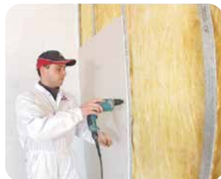
6: Steno zaključimo z oblogo iz mavčno kartonske plošče
