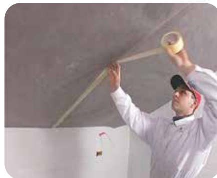
Slika 8: Vse spoje, preboje in priključke na foliji moramo zalepiti
