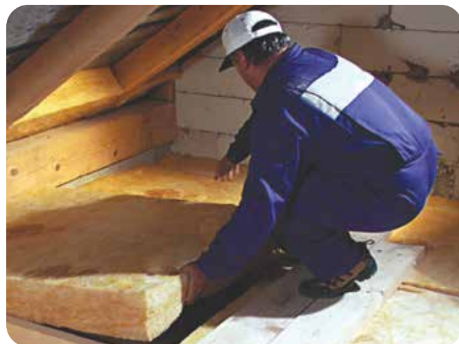
2. Polaganje drugega sloja - pri razrezu izolacije v plošče dodajte 10 % nadmere
