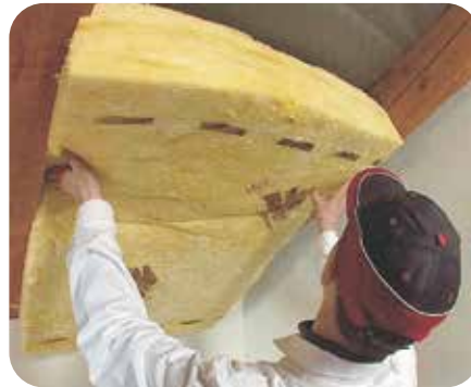
Slika 5: Izolacijo vstavimo med špirovce
