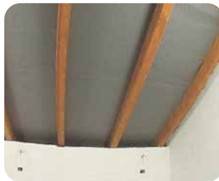
Slika 2: Predhodno položena paroprepustna folija - sekundarna kritina
