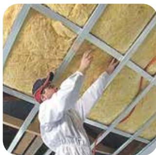
2. Postavimo prvi sloj izolacije
