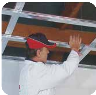
1. Postavimo kovinsko konstrukcijo
