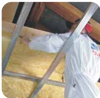
3. Postavimo drugi sloj izolacije
