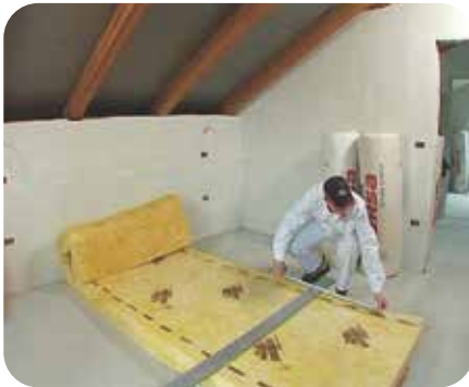
Slika 4: Izolacijo razrežemo na primerno velike plošče
