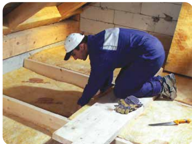
1. Polaganje prvega sloja izolacije med lesene distančnike
