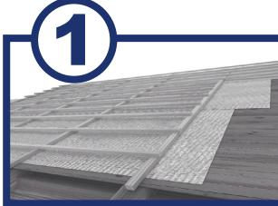
Membranu **Ursa** može se postaviti izravno na krovnu daščanu oplatu. Materijal je potrebo rastegnuti preko cijele površine krova.
