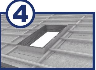
Preklapanja, otvor ili oštećenja na membrani **Ursa** moraju biti sanirani uz pomoć odgovarajuće samolepljive trake. Za spajanje s elementima krova upotrebljava se krovno brtivo ili butilna traka.
