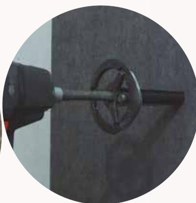
Fijación URSA TERRA Vento Plus P4203 con clavadora
