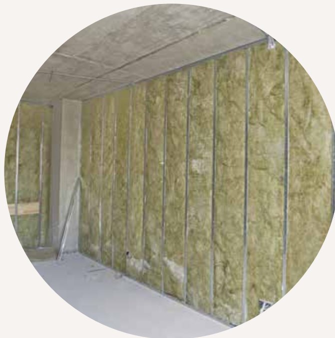
Cloison de plaque de plâtre PP 78/600(48) P
