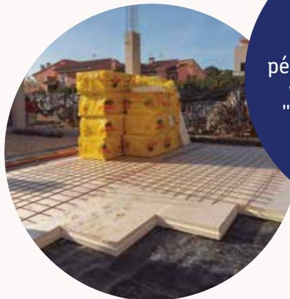
El aislamiento térmico para suelos URSA XPS evita la pérdida de energía entre viviendas y el efecto "radiación fría" en los sistemas con suelo radiante.
