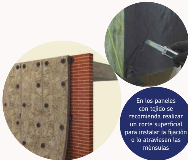
En los paneles con tejido se recomienda realizar un corte superficial para instalar la fijación o lo atraviesen las ménsulas
