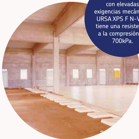
Para suelos con elevadas exigencias mecánicas, URSA XPS F N-VII L tiene una resistencia a la compresión de 700kPa.
