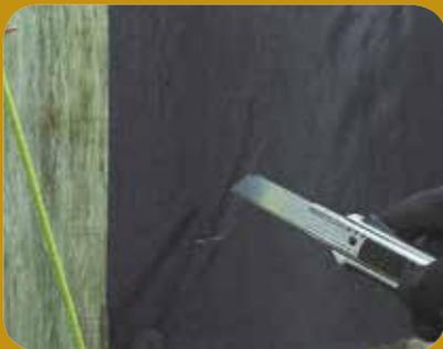
En los paneles con tejido se recomienda realizar un corte superficial para instalar la fijación o lo atraviesen las ménsulas
