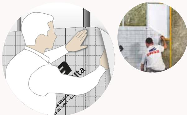
2. **Desenrollar la membrana** colocando su cara rugosa no impresa sobre el adhesivo de dos caras **URSA SECO®**.
