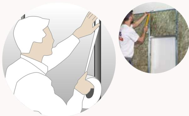
1. **Aplicar la cinta adhesiva de dos caras** directamente sobre el montante y después retirar la banda de protección.
