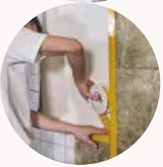
3. **Colocar bandas adicionales** para el tratamiento de los laterales verticales de la ventana (montaje con masilla o cinta adhesiva).
