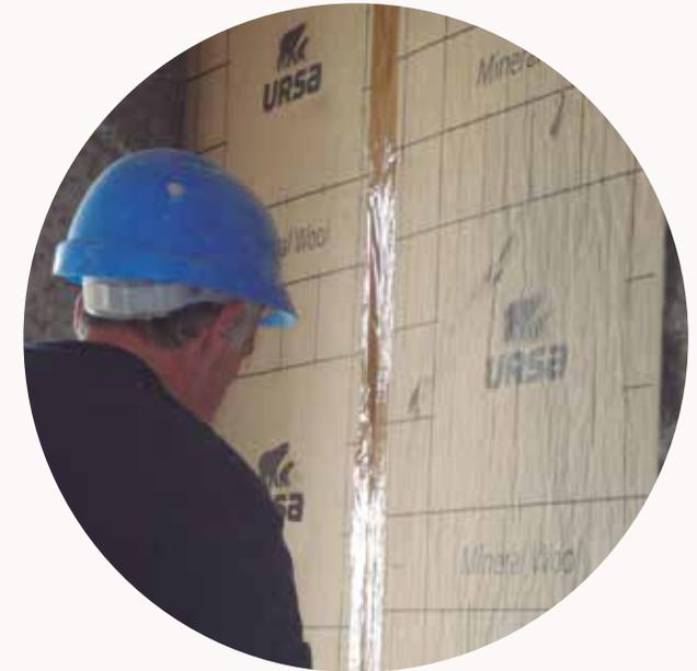
En caso de que el aislamiento no se pueda colocar a testa y aparezcan huecos (discontinuidad en el aislamiento), éstos se rellenarán con bandas o segmentos de la misma lana mineral, para conseguir una capa continua de aislamiento. La lana mineral URSA se corta con cuchillos o cuters de uso corriente.
