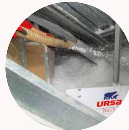
En el caso de las buhardillas no habitables, se puede combinar la lana insuflada con el sistema de barrera de estanquidad URSA SECO que además hace función de barrera de vapor, al colocarla directamente sobre el forjado y posteriormente insuflando la lana mineral con el espesor adecuado a la resistencia térmica necesaria.
