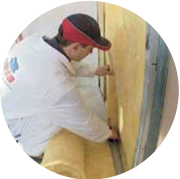
Slika 4: Izolaciju odrežite s dodatnih 2 cm više od svijetlog otvora visine konstrukcije
