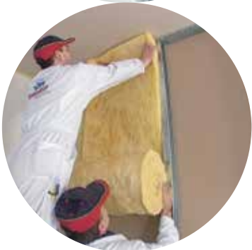
Slika 3: Postavite izolaciju u jednom komadu.
