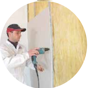
Slika 6: Zid završite oblogom od gips-kartonske ploče.
