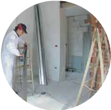
Slika 1: Nalijepite brtveću – dilatacijsku traku
