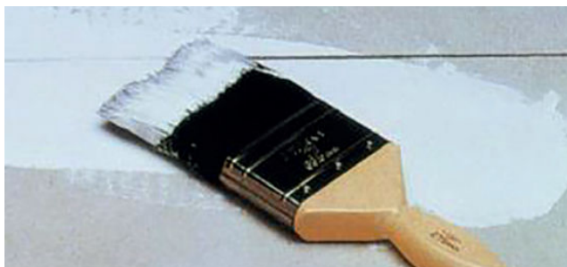
Preparazione del giunto con primer
