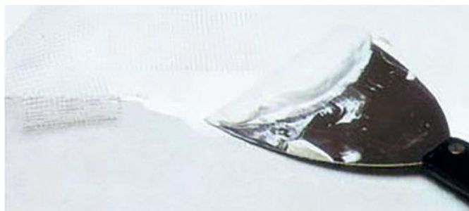
Applicazione di riempitivo per giunti
