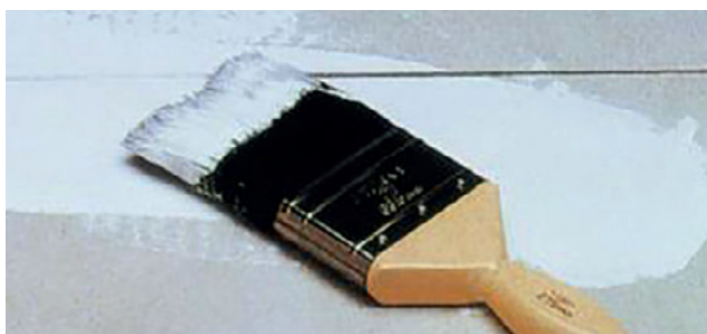
Preparazione del giunto con primer
