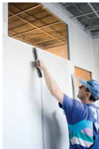
Nakładanie tynku na złącza przegród
