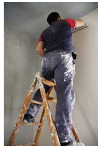
Nakładanie tynku na złącza pomiędzy ścianą a sufitem
