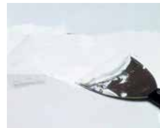
Nakładanie masy szpachlowej
