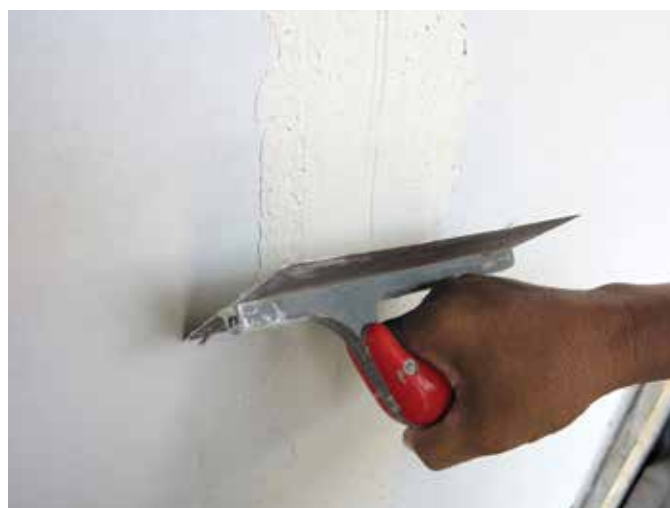
Nałożyć kolejną powłokę masy gipsowej w celu wykończenia
