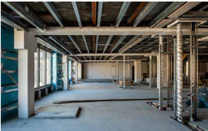
Herausforderung war die brandschutztechnische Bekleidung der historischen Stahlstützen mit vielen Durchdringungen.
