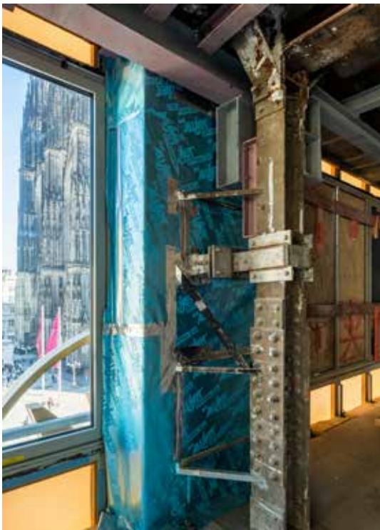
Herausforderung war die brandschutztechnische Bekleidung der historischen Stahlstützen mit vielen Durchdringungen.
