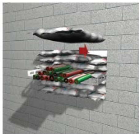
5. Cierre la abertura con las almohadillas cortafuego, éstas deben ser acomodadas en la forma que se escalonan los bloques de mampostería y deben quedar muy ajustadas. Es muy importante que no se dejen huecos o aberturas entre las almohadillas.
