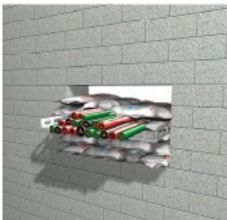
4. Cubra los cables o tuberías con las almohadillas.
