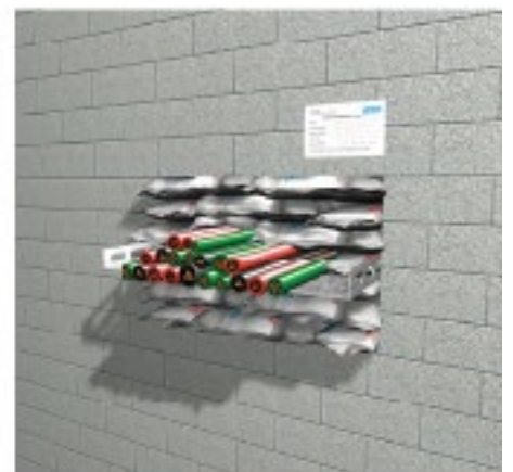
6. Instale la etiqueta de identificación.
