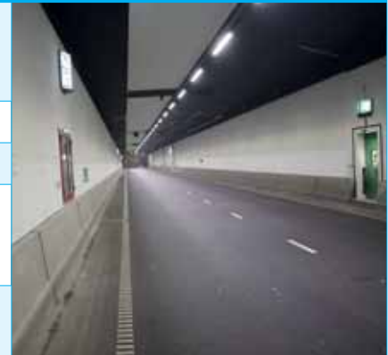
Projet de rénovation avec PROMATECT®-T.
