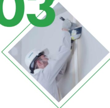
Presionar la cinta sobre la placa y retirar lentamente el exceso de Masilla en polvo Gyplac
