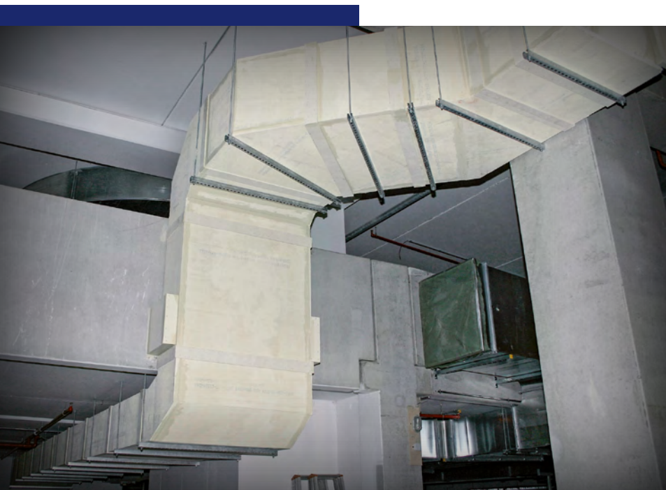
Selbständige PROMATECT®-LS-Lüftungsleitungen
