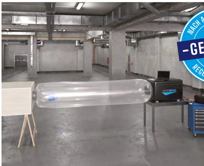
Abdichtung von Leckagen mit dem AEROSEAL®-Verfahren an einem Test-Kanalsystem
