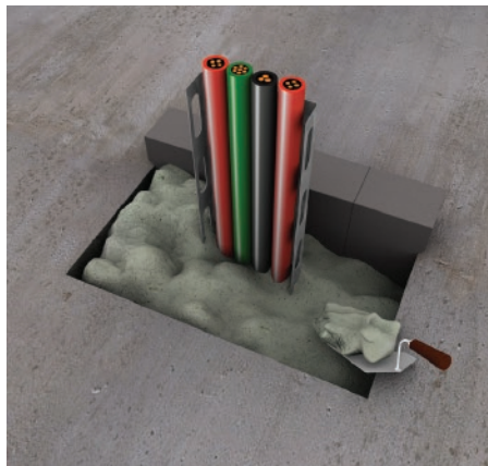
5. Cerrar el remante de abertura con PROMASTOP®-M. Considere que para tamaños grandes de aberturas y penetraciones, se requiere trabajar con la viscosidad del producto para alcanzar espesor o altura correctos.
