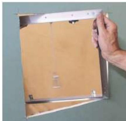
Mida la diagonal sobre en las esquinas. Si ambos tramos tienen la misma longitud, entonces está  $A=B=OK!$
