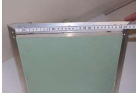
Preparación de la abertura. Dimensión de apertura = Dimensiones de montaje + 7 mm., realice el corte.
