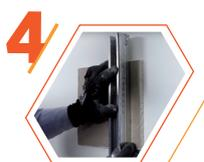
Por la cara posterior trace con el bisturí las medidas del hueco.
