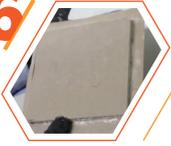
La pieza central es el hueco a reparar y los lados sirve de refuerzo para masillar.
