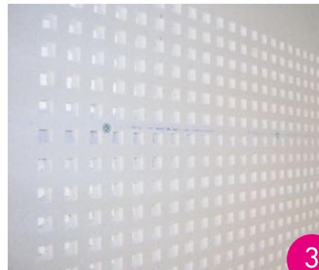
Cuando la estructura está ubicada cada **60 cm**, la placa se fija **perimetralmente** y en las fajas sin perforaciones.
