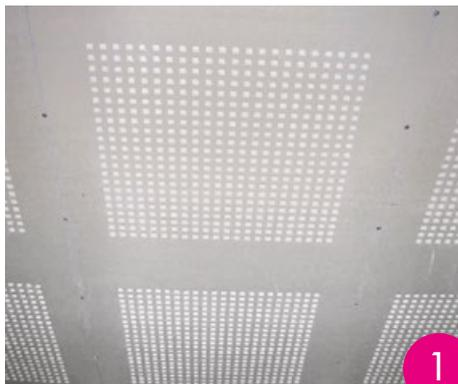
Las placas se **fijan perimetralmente y en el centro**, evitando dañar las perforaciones que traen las placas de fábrica, siguiendo el mismo criterio y distanciamiento de tornillos que las placas convencionales de yeso para cielos. (Fig.01).
