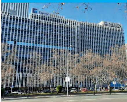
EDIFICIO OFICINAS CASTELLANA 83-85 (MADRID)
