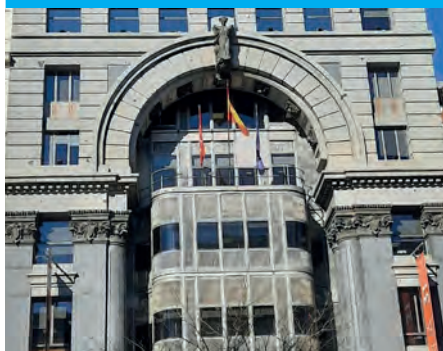
REFORMA EDIFICIO C/ALCALÁ 31 (MADRID)
