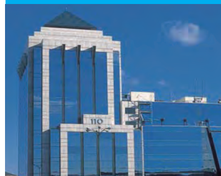
EDIFICIO CASTELLANA, 110 (MADRID)
