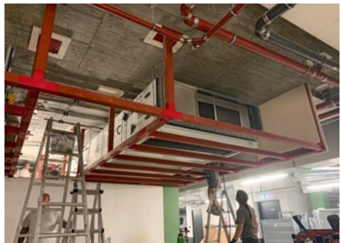
Konstruktion 420.51 Beispiel: als eigener Brandabschnitt für Lüftungsgeräte
