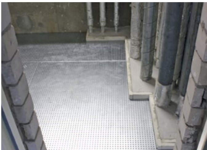
Konstruktion 420.51 Beispiel: begehrbar mit Rohrabschottung
