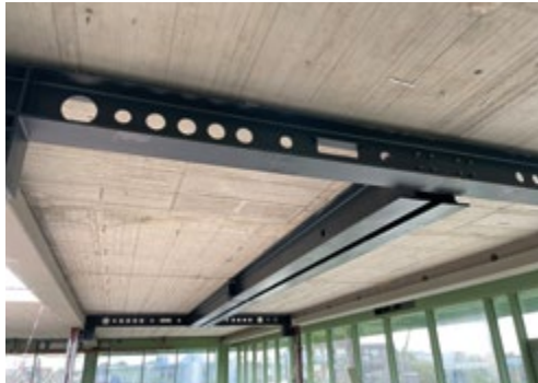
Stahltragwerk im Gebäude vor der brandschutztechnischen Bekleidung mit PROMATECT®-Brandschutzbauplatten.
