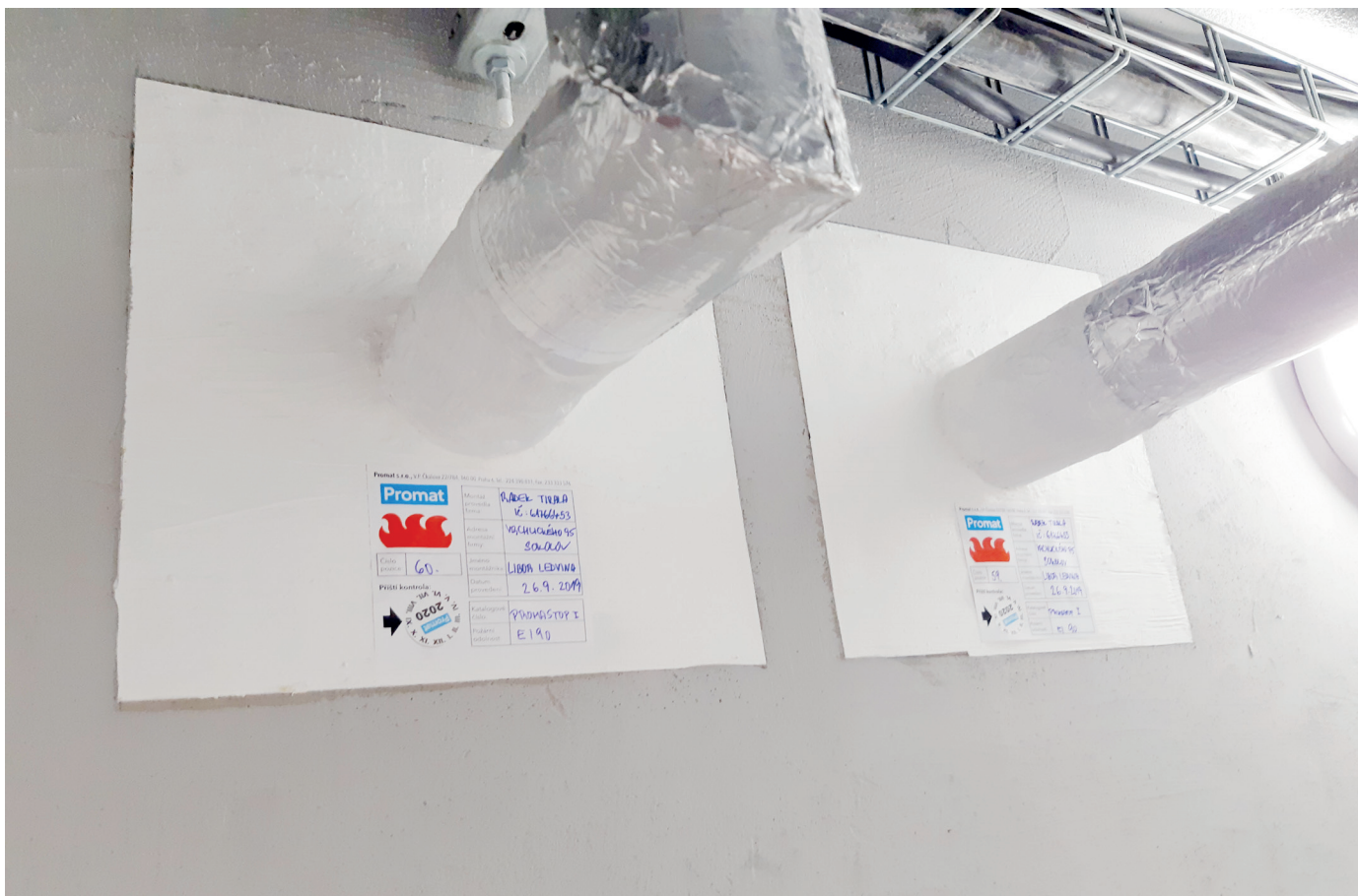
Prostup ocelového potrubí s nehořlavou izolací a stěrka PROMASTOP®-I
