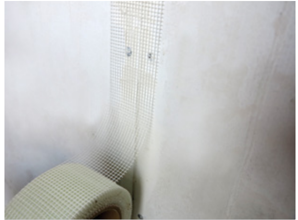
Vyplňte priestor spoja tenkou vrstvou tmelu a prekryte výstužnou páskou.
