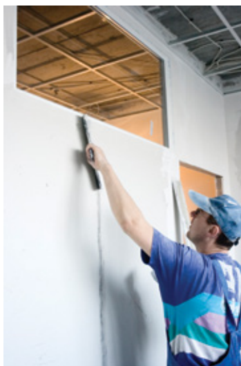
Nanášanie omietky na priečky (hore vľavo) a na spojoch stien a stropov (hore vpravo)
