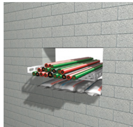
3. Prvi sloj protivpožarnih jastuka treba da se postavi ispod kablova i/ili cevi.
