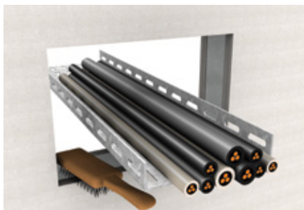
1. Očistite otvor i instalacije
