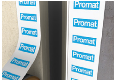
2. Ako je potrebno, zaštitite radnu površinu na zidu/podu pokrivajući je trakom
