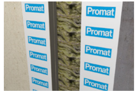
3. Umetnite materijal za ispunu tako da se obezbedi čvrsto zaptivanje (negorivi materijali ili gorivi materijali)
