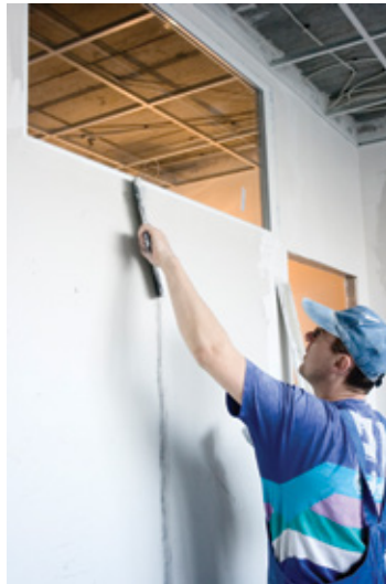
Gletanje spojeva ploča na pregradama ( gore lijevo) i spojeva zidova i stropova (gore desno)
