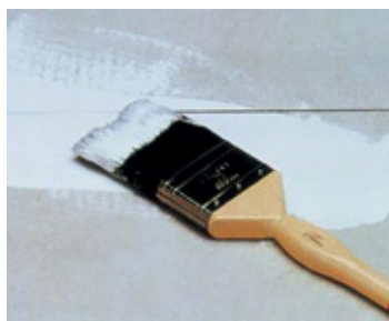
Priprema spoja s predpremazom
