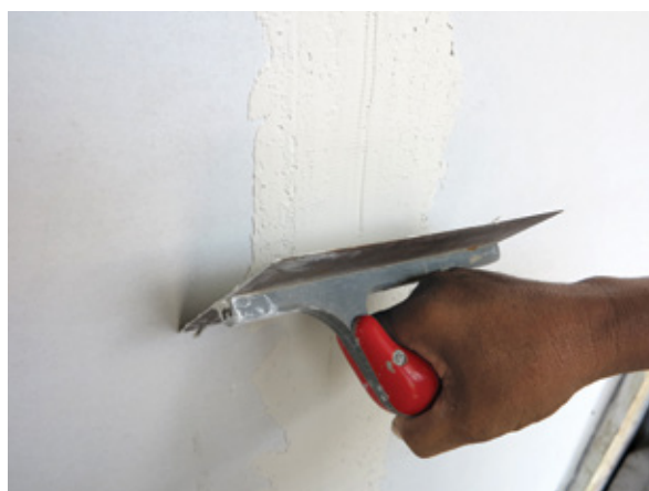
Nanesite dovoljnu količinu mase za ispunu da završite gletanje
