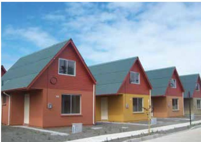
Atap Gelombang Eter selain digunakan untuk atap bangunan dapat digunakan sebagai dinding luar bangunan, dengan menggunakan atap gelombang Eter sebagai dinding luar.
