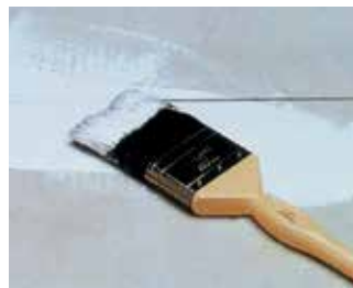
Przygotowanie złącza z pomocą gruntu
