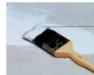
Przygotowanie złącza z pomocą gruntu
