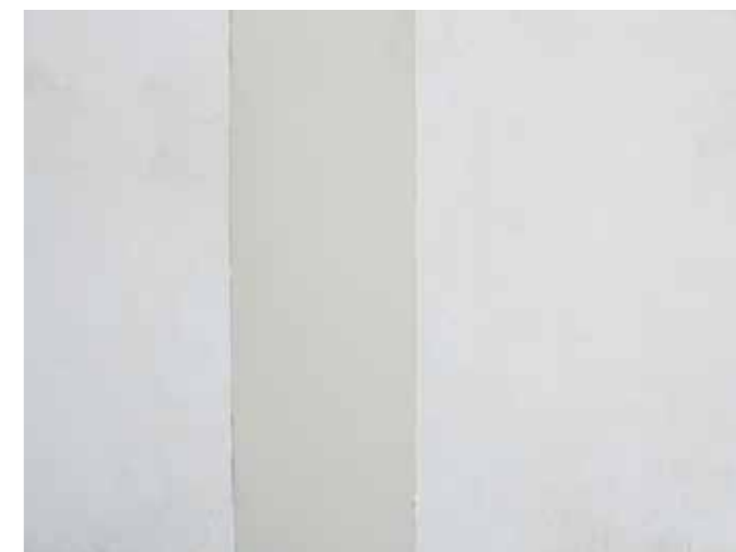
Złącze po finalnym wykończeniu pacą
