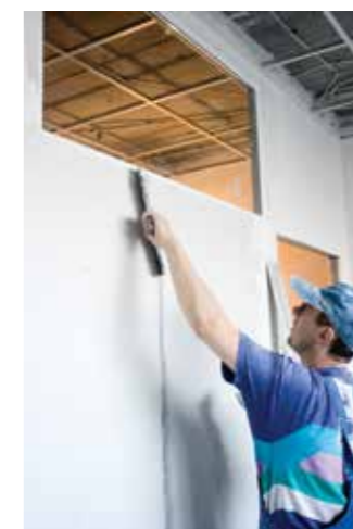
Nakładanie tynku na złącza przegród
