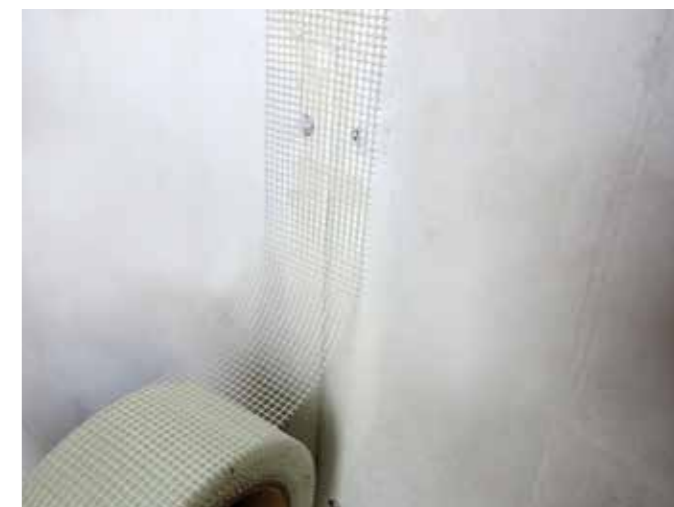
Złącze należy wypełniać pojedynczą, cienką warstwą gipsu, na który należy nałożyć siatkę wzmacniającą.
