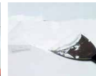
Nakładanie masy szpachlowej
