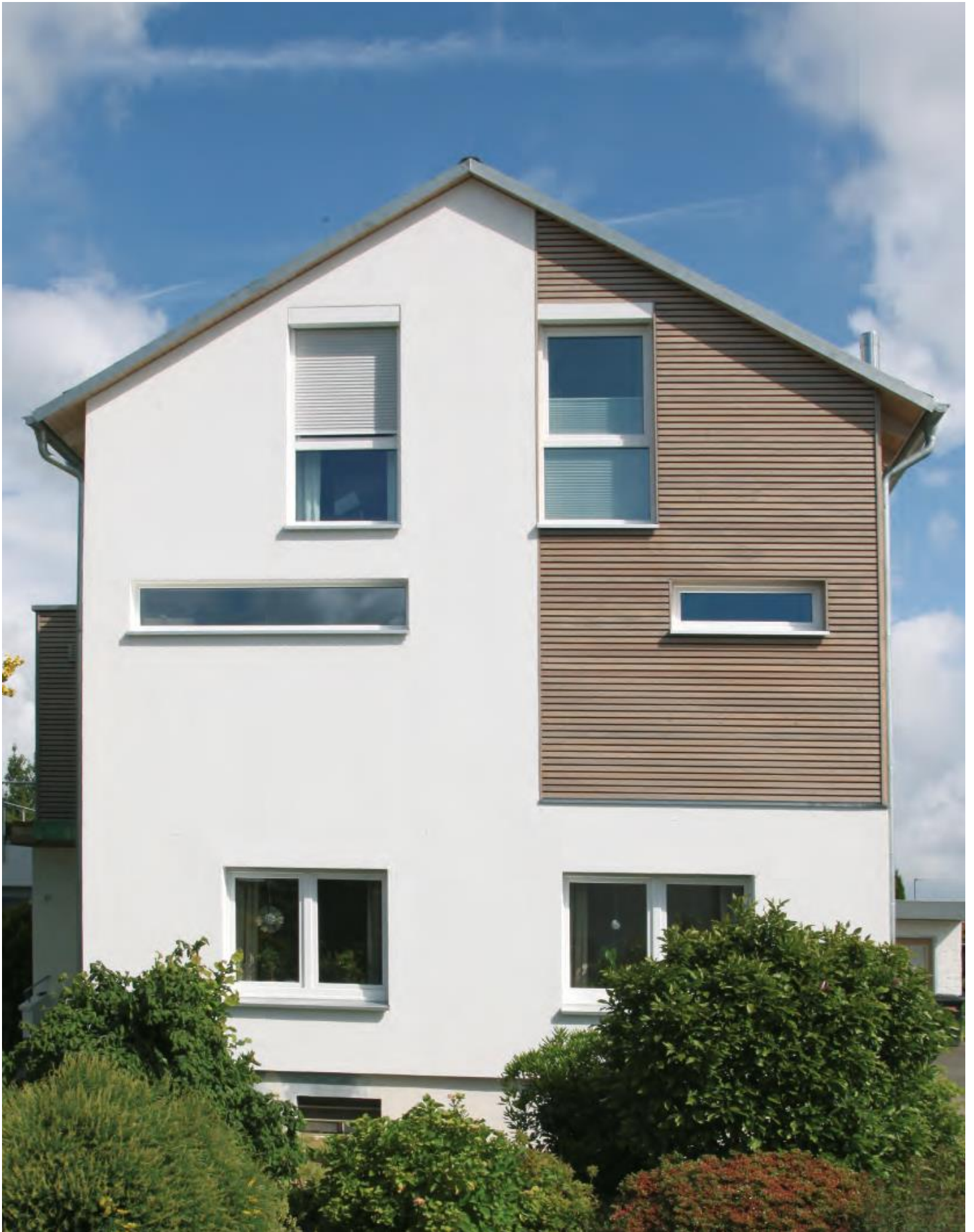
Aufstockung und Sanierung Doppelhaus, Herford Architekt: Daniel Sieker, Bielefeld Produkte: Cedral Bluclad Putzträgerplatten Foto: Stefan Fischer, Borgholzhausen
