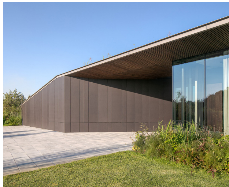
Private House in Poland Einfamilienhaus in Polen Maison individuelle en Pologne
