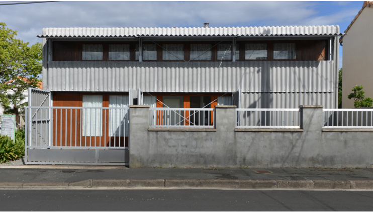
Renovation of Latapie House in Bordeaux Renovierung des Latapie Hauses in Bordeaux Rénovation de la maison Latapie à Bordeaux
