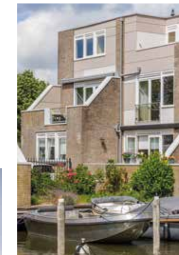
32 Renovatie 18 appartementen Alphen aan den Rijn Alphen-sur-le-Rhin Rénovation de 18 appartements
