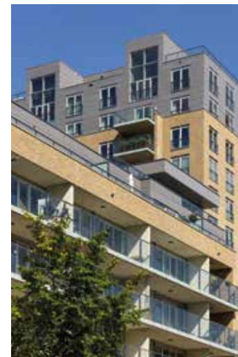
18 Woningbouw Stadhouders Den Haag La Haye Construction de logements « Stadhouders »
