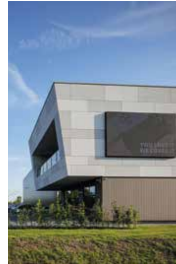
4 Constructie van een nieuw gebouw voor een e-commercebedrijf Leusden Leusden Construction d'un nouveau bâtiment pour une entreprise d'e-commerce
