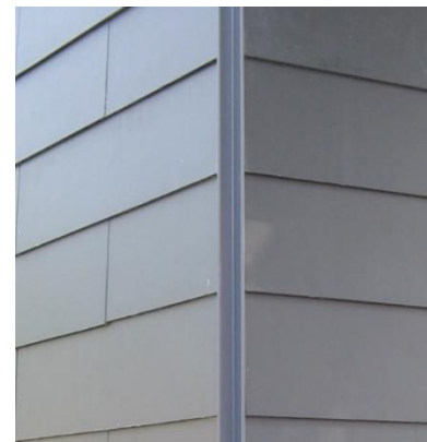
Foto 1: Voorbeeld van een afwerking van een buitenhoek (leien in halfsteensverband)
