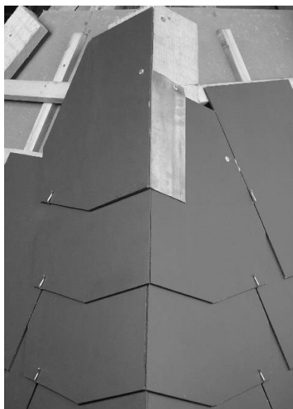
Photo 3: Arêtier avec des ardoises taillées en biais
