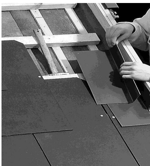
Photo 11: Fenêtre de toiture
