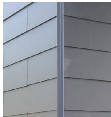
Photo 14: Exemple d'une finition d'angle extérieur
