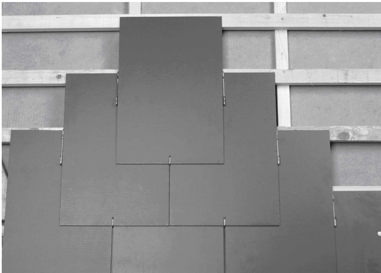
Photo 1 : Fixation avec crochets
