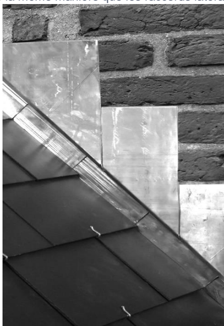
Photo 12 : Raccord de mur
