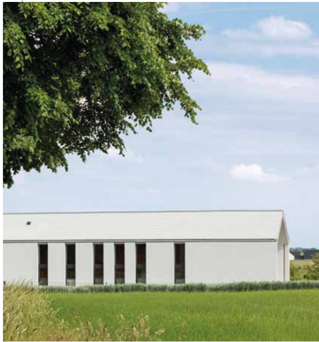
Walhain - Atelier d'architecture Mathen (Corbais)
