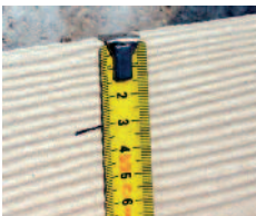
③ Recouvrement de 30 mm
