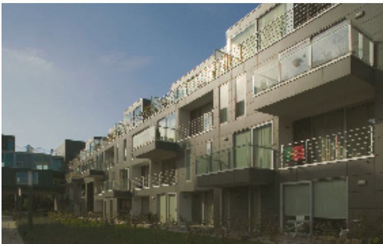
Zicht op de achterzijde van het gebouw
