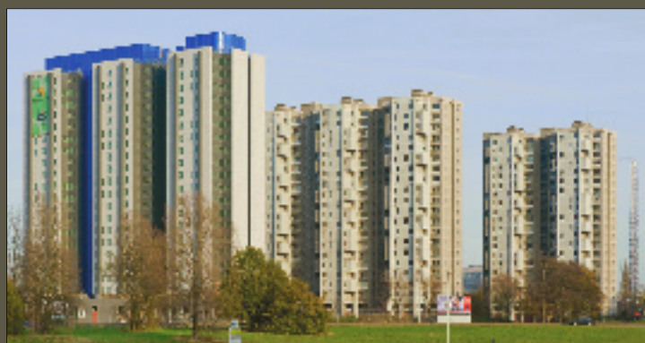
8 Algemeen zicht op de 3 woontorens, waarvan twee reeds afgewerkt. Renovatie derde woontoren wordt in 2009 gestart. Vue d'ensemble des 3 tours, dont les deux premières sont déjà rénovées. La rénovation de la troisième tour débutera en 2009.
