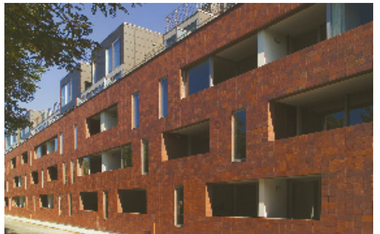
Vue sur la façade avant du bâtiment
