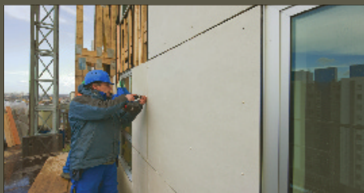
6 Plaatsen van nieuwe gevelbekleding Eter-Color. Pose du nouveau revêtement de façade Eter-Color.
