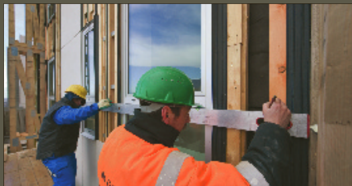
5 Uittlijnen van de houten draagstructuur. Alignement de la structure portante en bois.
