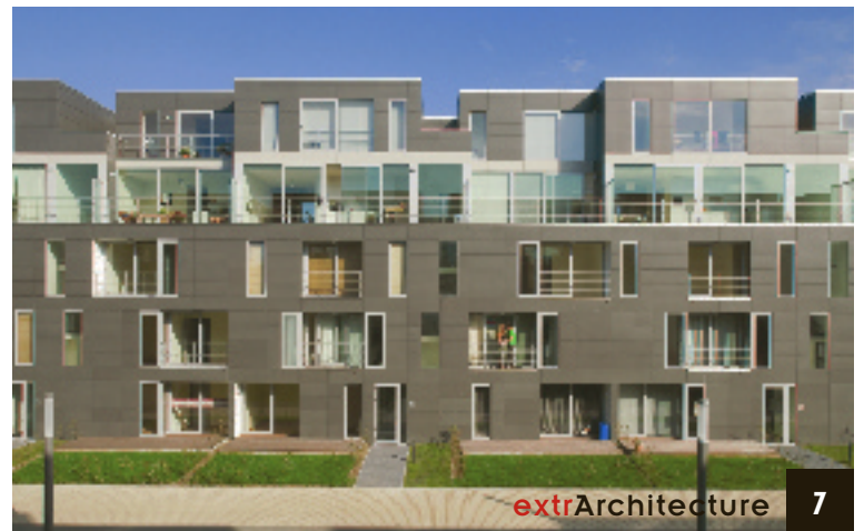
Vue sur la façade arrière du bâtiment
