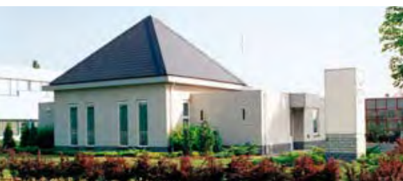
Bestaand gebouw voor de renovatie Bâtiment existant avant les rénovations
